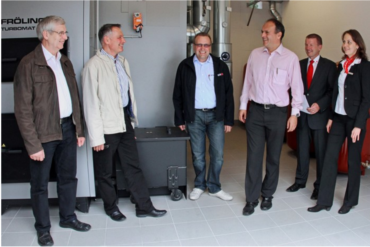
Die Besichtigung eines guten Ergebnisses. Im Heizungsraum der Ritter Pen GmbH (von links): Fredy Büchler und Jürgen Riedel, beide Geschäftsführer der Ritter Pen GmbH, Werner Germann, Geschäftsführer Germann GmbH, Arno Ritter, geschäftsführender Inhaber Ritter Pen, sowie Stefan Hartmann, Sparkassen Betriebswirt, und Heike Schmiedl, Marketing, beide von der Sparkasse Odenwaldkreis
